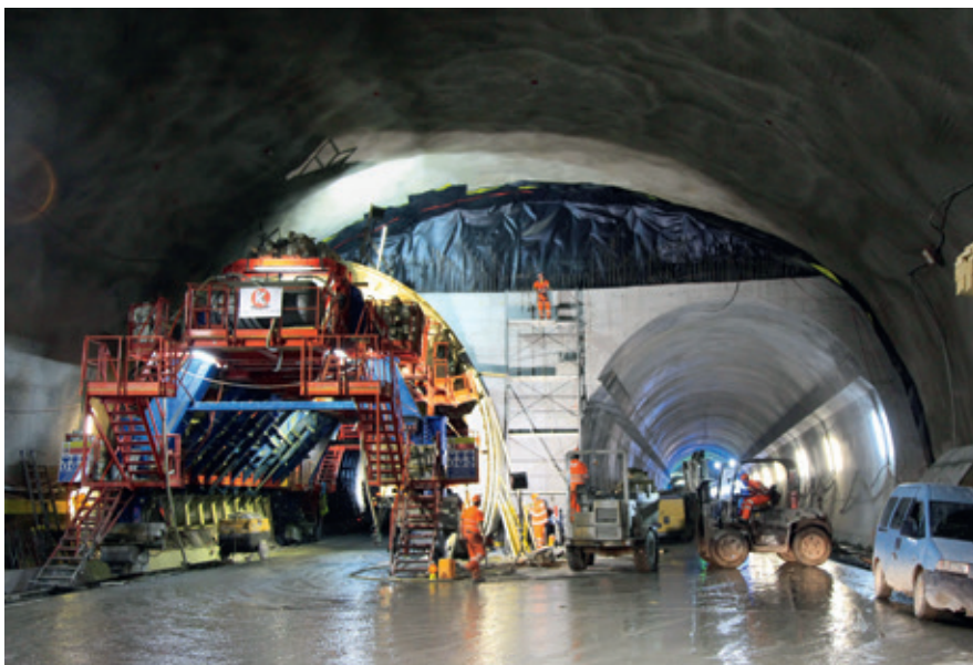
Der Tunnel von Visp ist als Verzweiger Teil des neuen Autobahnabschnitts der A9 im Wallis.
