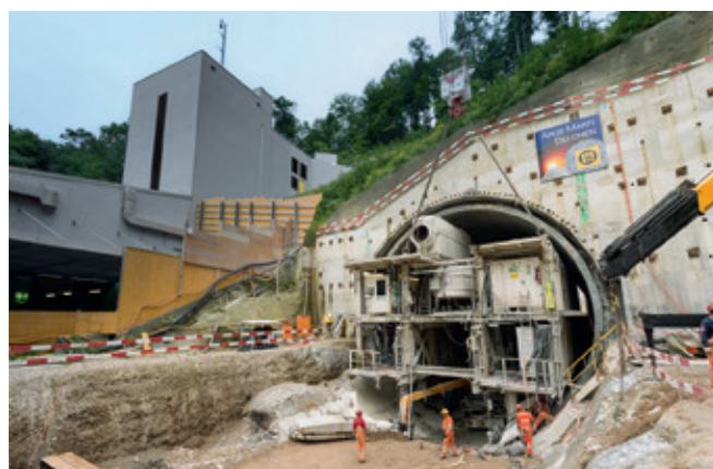
Die Arbeiten am Belchentunnel, unten das Südportal im Kanton Solothurn.
